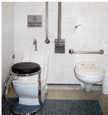
WM COMPACT MIT LEICHT ZUR SEITE SCHIEBBAREM HOCKER FÜR ROLLSTUHLGERECHTEN ZUGANG
