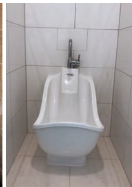
WM COMPACT AVEC LE TABOURET RETIRÉ POUR FACILITER L'ACCÈS DU FAUTEUIL ROULANT
