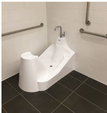
WM CLASSIC AVEC BARRES D'APPUI ET ESPACE POUR L'ACCÈS DU FAUTEUIL ROULANT
